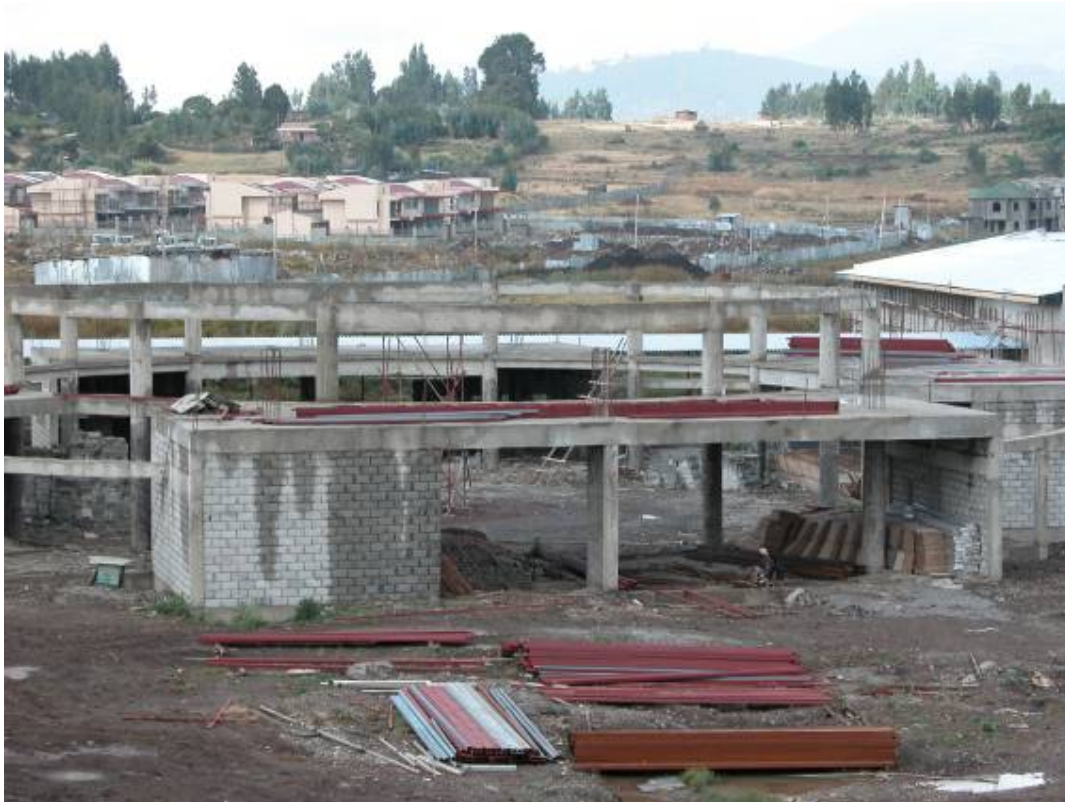
Workers are preparing the manufacturing of the roof trusses for the Multi-Purpose Hall. (Werkers zijn bezig met het samenstellen van de dakspanten voor de zaal, die voor meerdere doeleinden is te gebruiken.)
