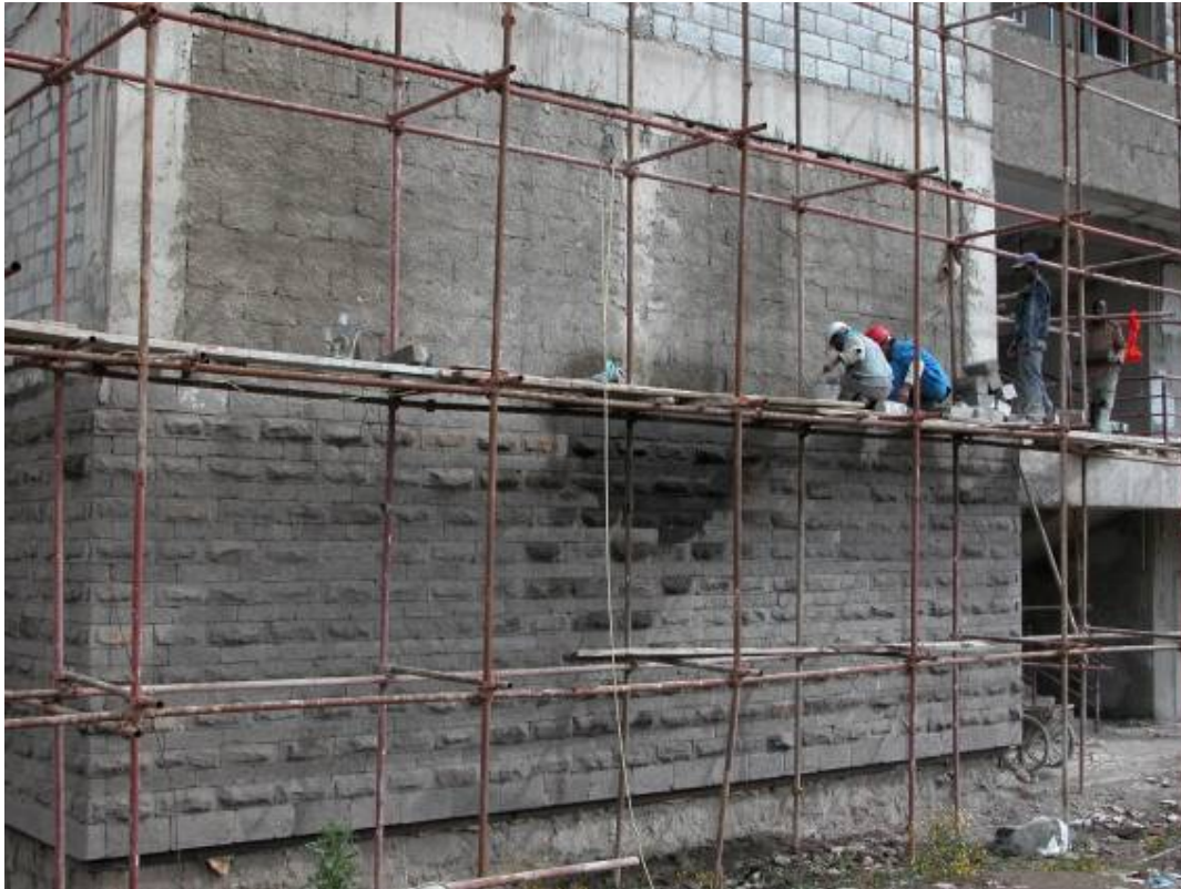
Laying the stone cladding at Classroom F. (Het aanbrengen van de natuurstenen bekleding voor Classroom F.)
